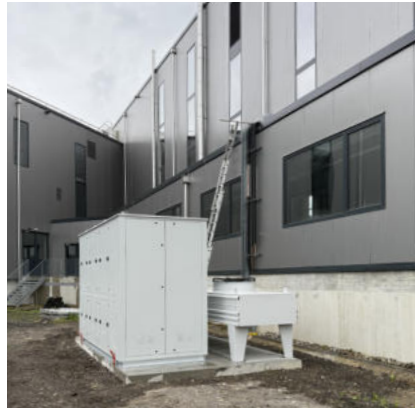
Cellules de surgélation, chambres de fermentation, espaces réfrigérés et surgelés : Kolb Kälte a réalisé l'ensemble du système de froid et de fermentation, incluant la technologie CO 2 , la régulation et la finition hygiénique – sur mesure pour la production Bridor.
